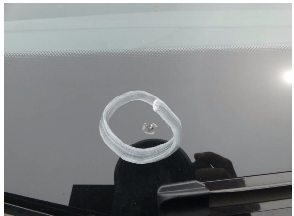
Bild 26: Frontscheibe Steinschlag - erneuern
