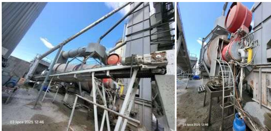
Widok ogólny – zbiornik na olej opałowy
