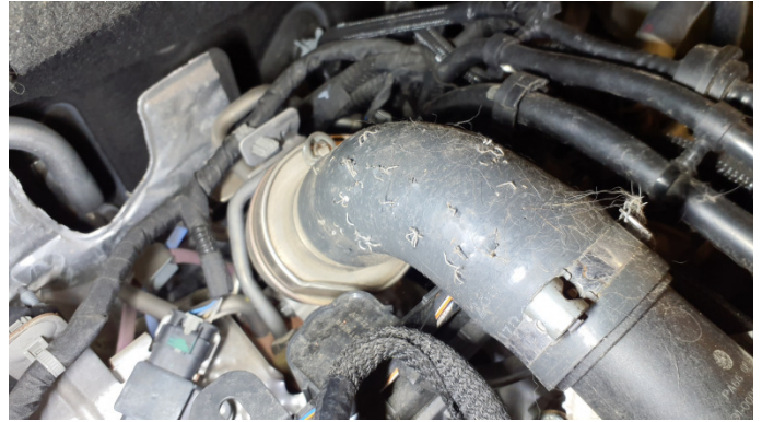
25. Ladeluftschlauch vor LLK Beschädigt -
