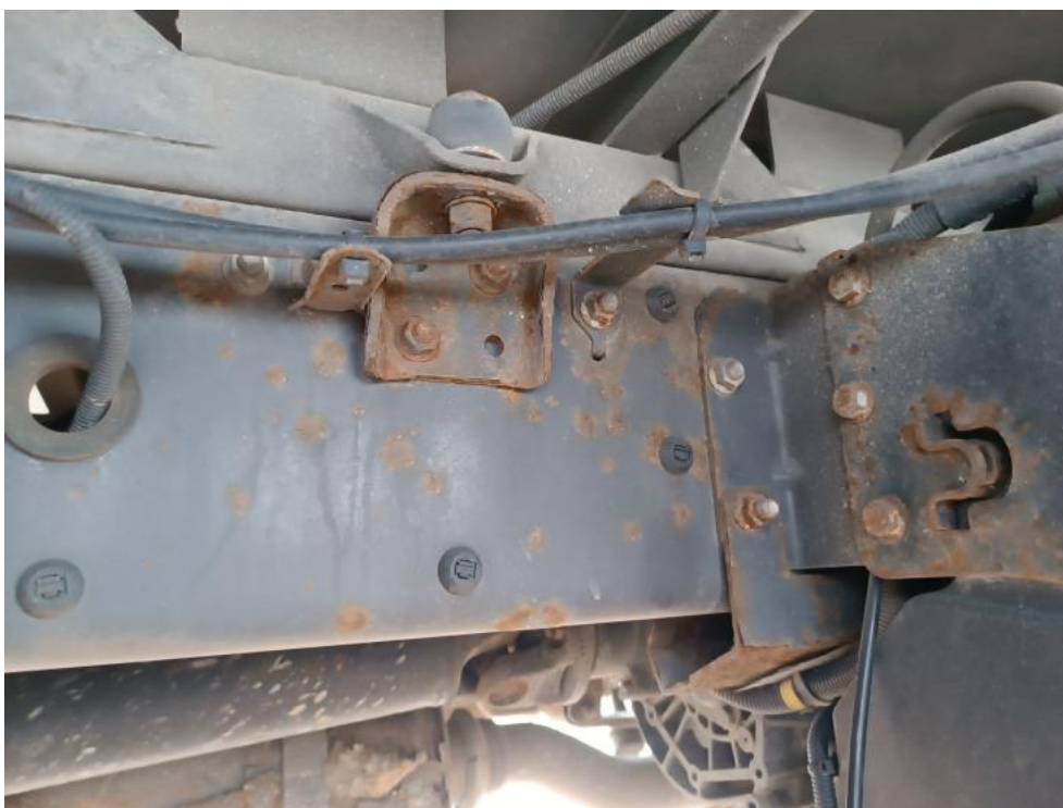
Fot. 85. Rama - korozja 1
