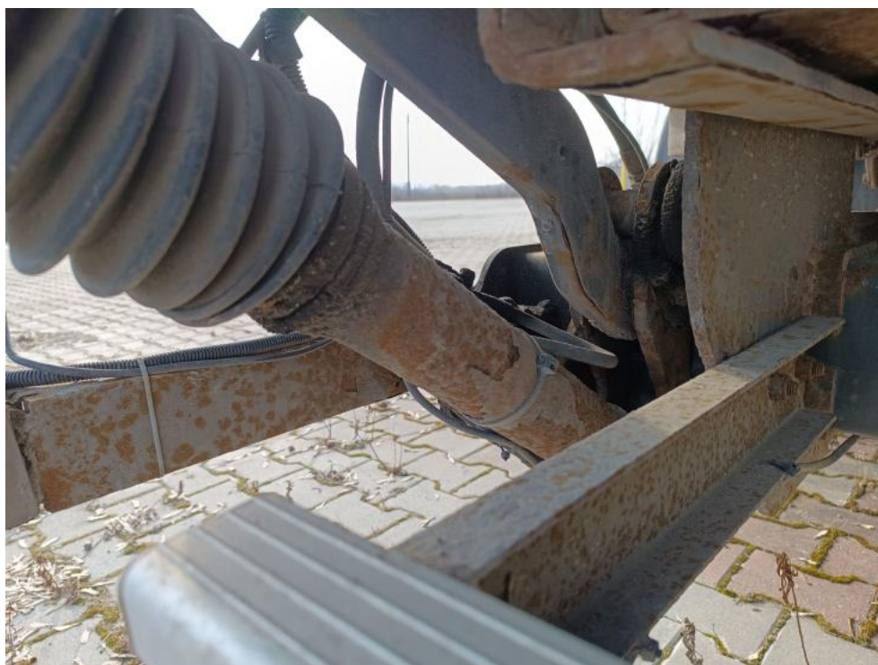
Fot. 52. siłowniki korozja
