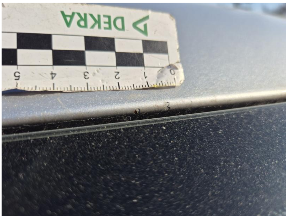
Fot. 49 Dach - Inne 1
