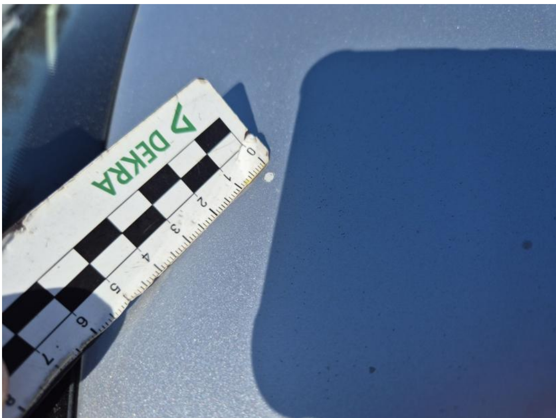
Fot. 48 Dach - Rysa/odprysk 1
