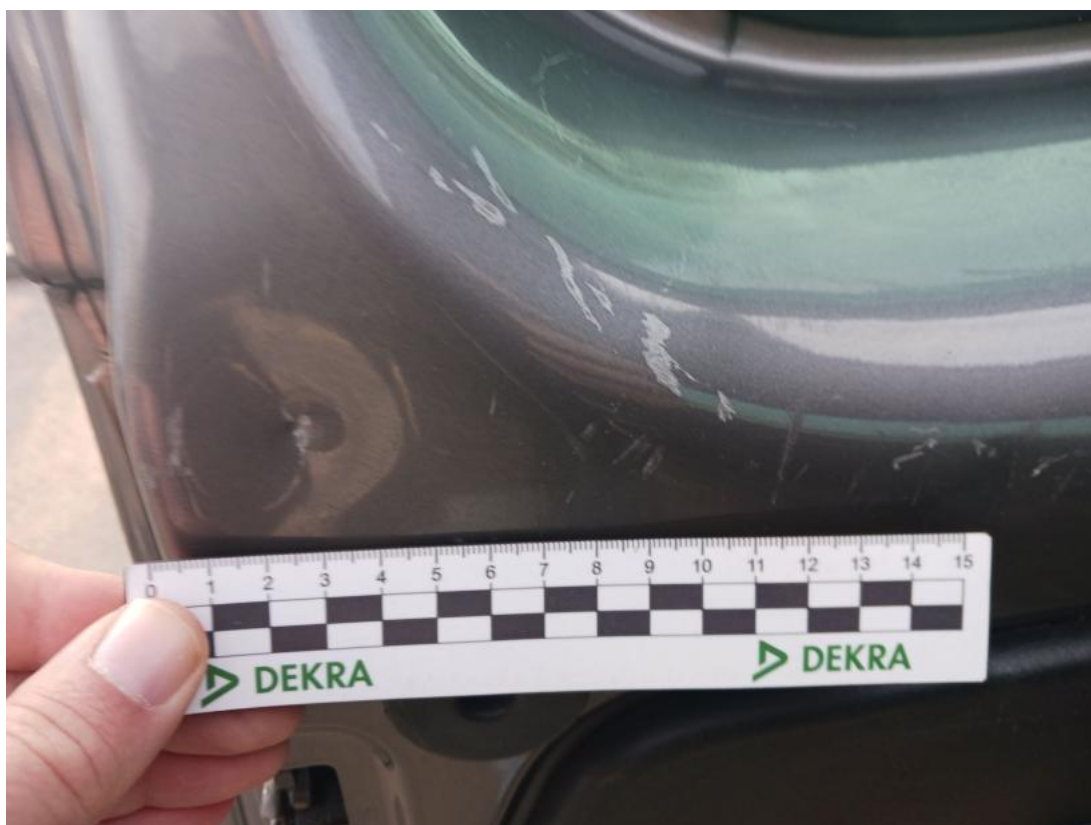
Fot. 76 Drzwi - Wgniecenie/odkształcenie 1
