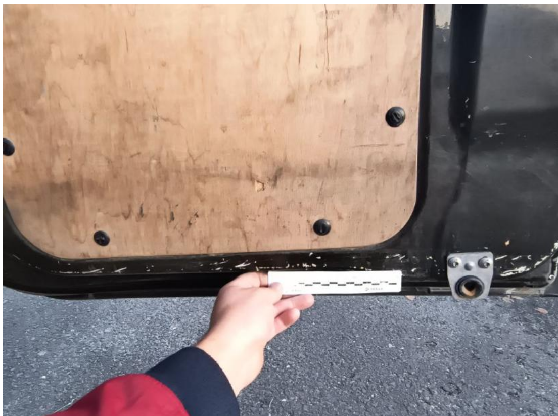
Fot. 107 Drzwi tyłu prawe - Rysa/odprysk 1
