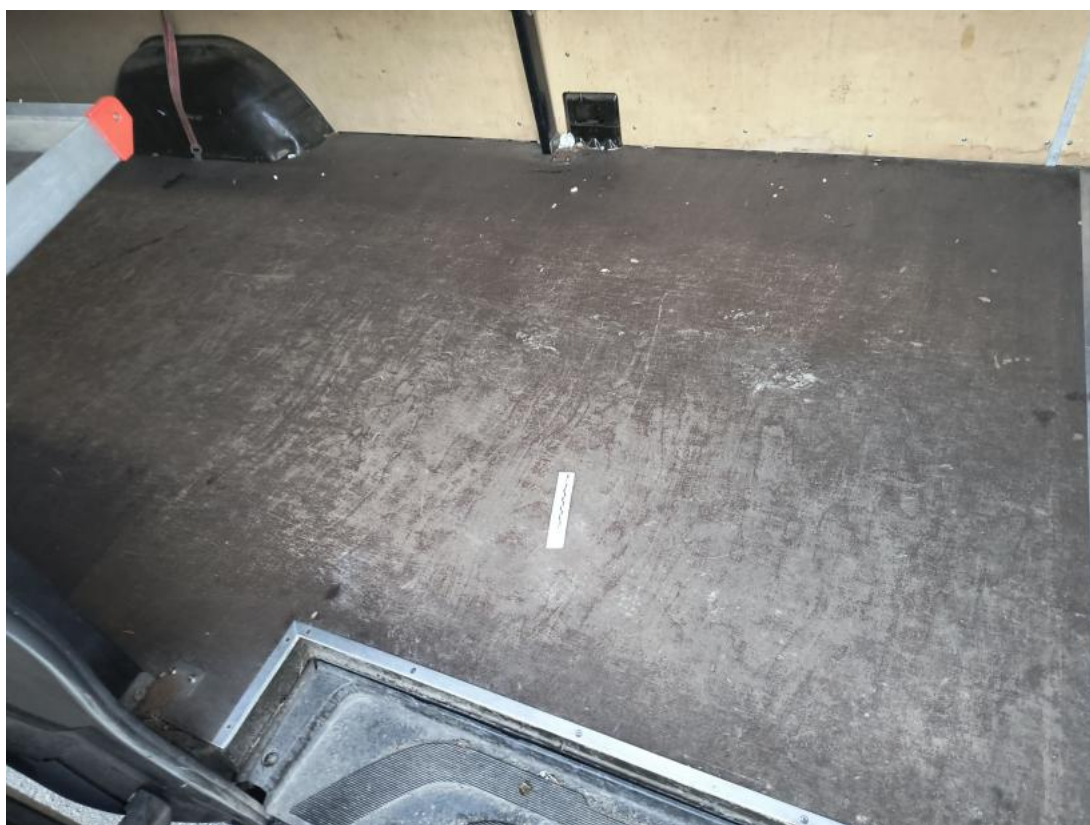
Fot. 108 Podłoga - Rysa/odprysk 1
