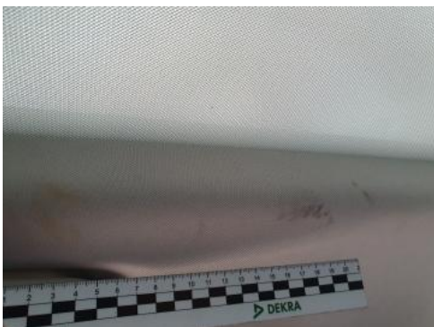
Fot. 51 Podsufitka - Inne 1
